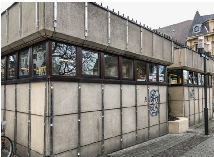
Der Fachbetrieb verschraubte die Unterkonstruktion aus Aluminium direkt an der Betonwand
